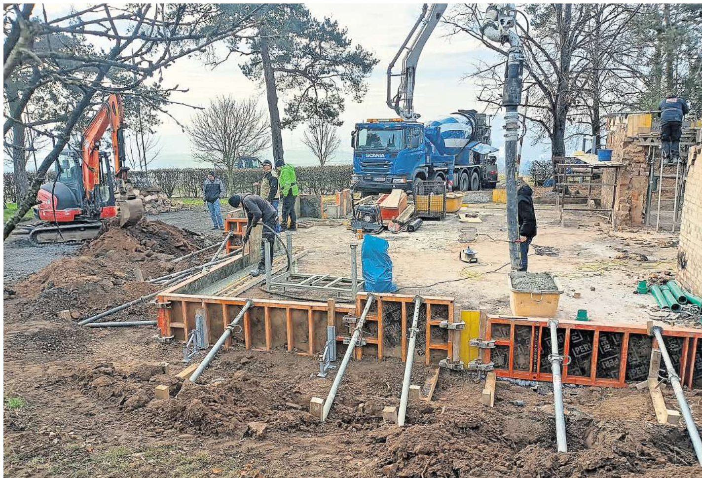
Die Betonarbeiten für die Bodenplatte bei der Grillhütte in Langenstein haben begonnen.
